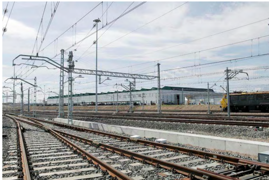
Fig. 3.15. Vista de la playa de vías más edificio técnico. Fuente: Adif
