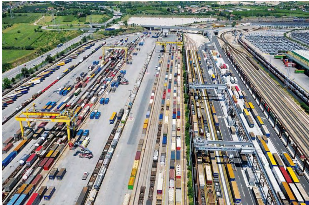
Fig.3.4. Terminal intermodal Quadrante Europa. Fuente: Interporto Quadrante Europa
