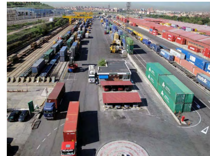
Fig. 3.23. Vista global del complejo Abroñigal. Fuente: Adif
