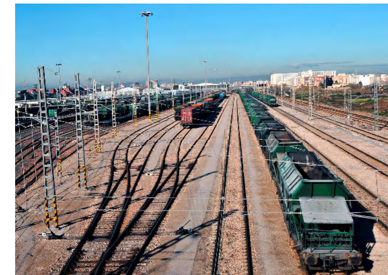
Fig. 3.17 y 3.18. Maniobras dentro del centro. Fuente: Adif
