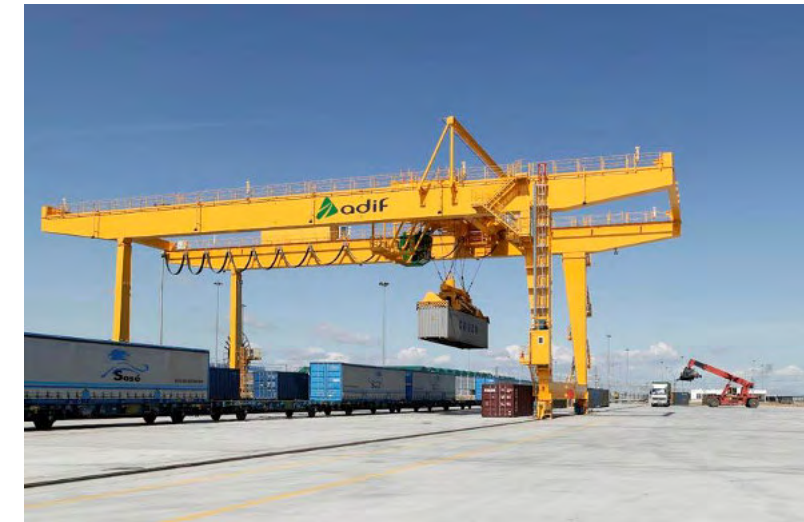
Fig. 3.14. Maniobras en la terminal con grúa pórtico. Fuente: Adif
