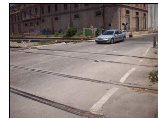
p.k. 396.38 -> PASO A NIVEL DE LA CALLE ALTOS DE LA CONDOMINA
