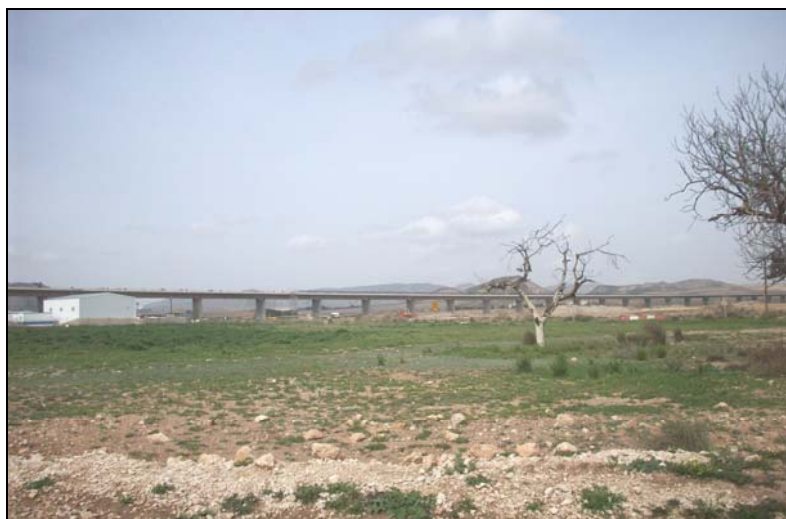
VIADUCTO SOBRE EL CORDEL DEL CAMINO DE SAX POR CARBONEROS. TRAMO VILLENA-SAX
