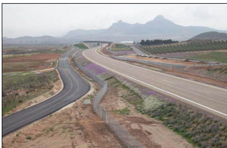
PLATAFORMA DE LA LÍNEA DE ALTA VELOCIDAD EN VILLENA. TRAMO VILLENA-SAX
