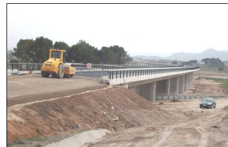
OBRAS DEL VIADUCTO SOBRE LA ACEQUIA DEL REY Y LA CARRETERA CV-813. TRAMO VILLENA-SAX
