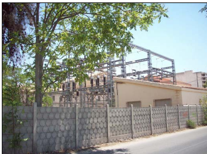
P.K. 396.31 -&gt; SUBESTACIÓN ELÉCTRICA
