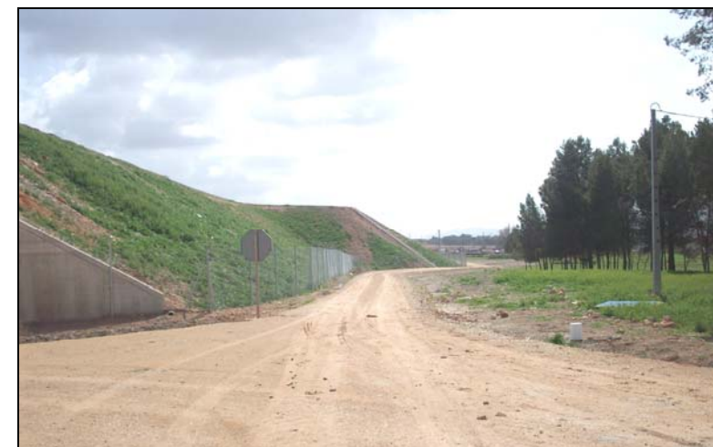
PLATAFORMA DEL PUESTO DE BANALIZACIÓN EN EL TRAMO CAUDETE- VILLENA
