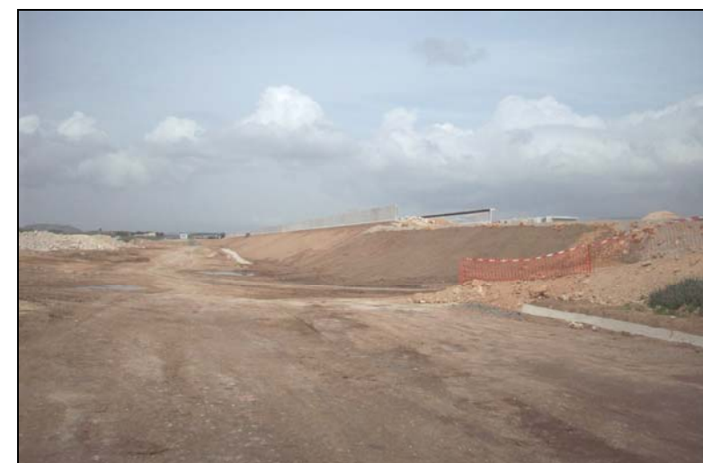
OBRAS DEL PAET DE LA LINEA DE ALTA VELOCIDAD EN EL TRAMO VILLENA-SAX.
