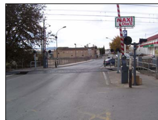
p.k. 395.60 -> PASO A NIVEL DE LA CARRETERA CV-81
