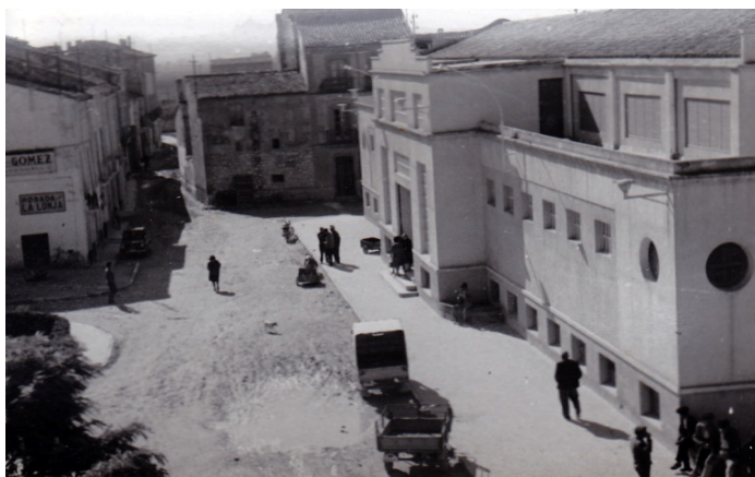
FACHADA DEL MERCADO DE LA PLAZA DEL ROLLO
