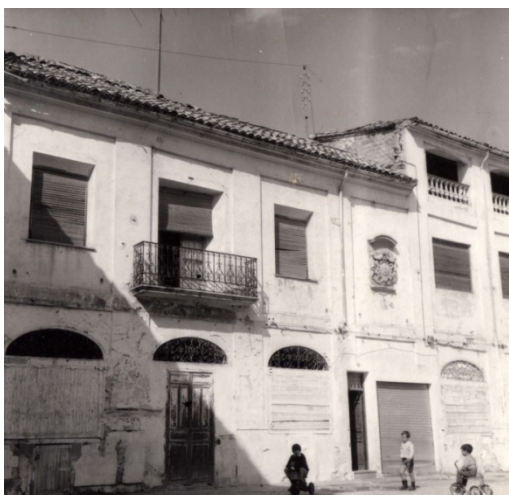
VISTA DE LA PLAZA MAYOR DONDE SE APRECIAN LAS CASILLAS DE VENTA, YA CERRADAS.
