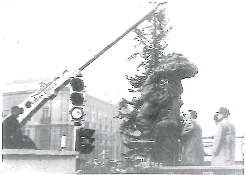
Montaje en la Puerta del Sol. Madrid
