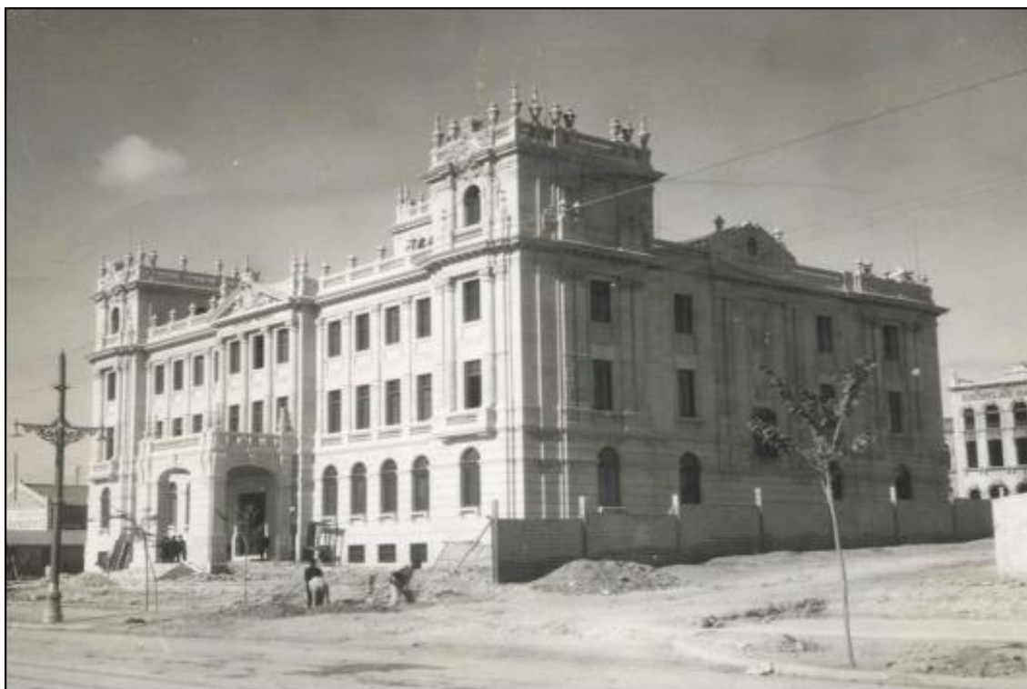
Fig. 3. Obras de construcción del Palacio de la Diputación Provincial. 1931. Archivo Histórico Municipal de Alicante. Colección Francisco Sánchez.
