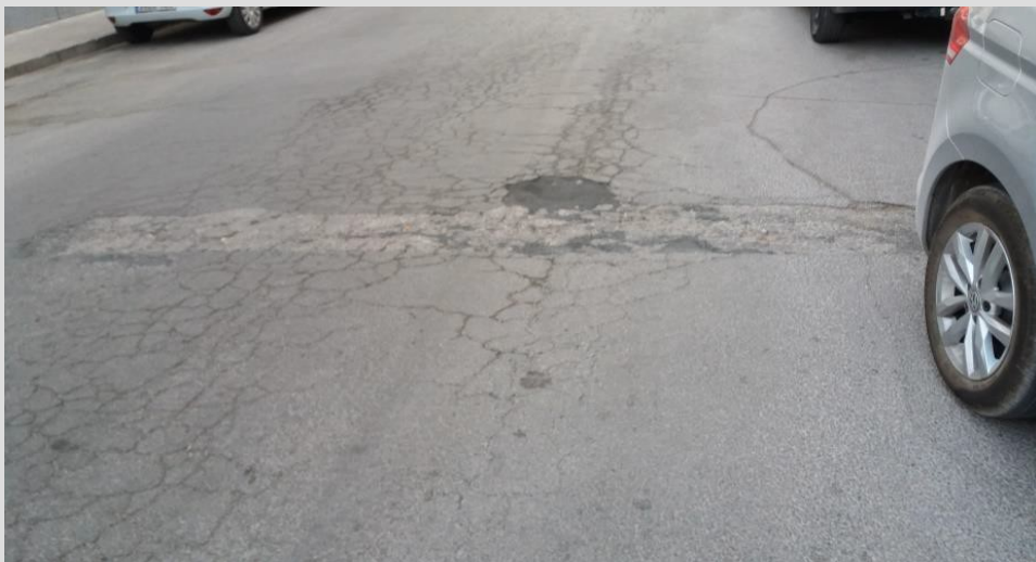
Degradación de la capa de rodadura (cuarteo en malla gruesa), con reparación de socavones.
