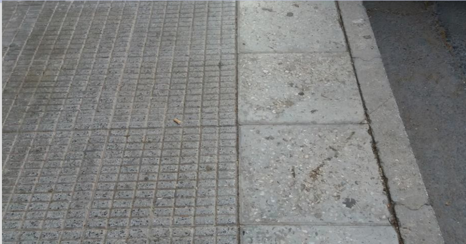
Reposición de baldosa con material de alta resbaladidad.
