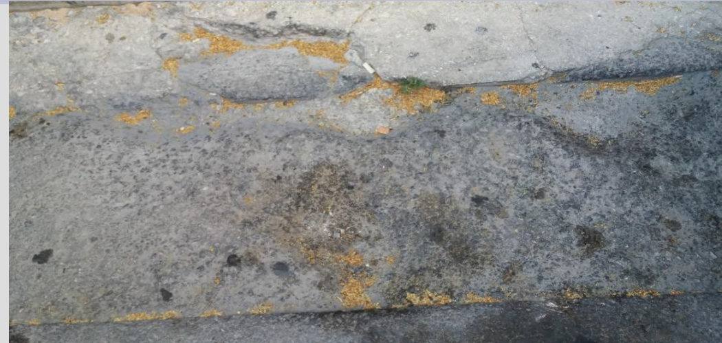
Estado de capa de rodadura en zona de estacionamiento.
