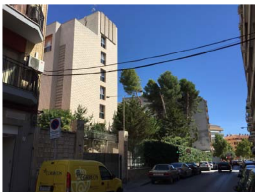
CALLE FERRIZ · VISTA ACTUAL
