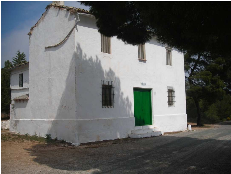
Dirección, uno de los edificios de servicios que quedan en la Colonia
