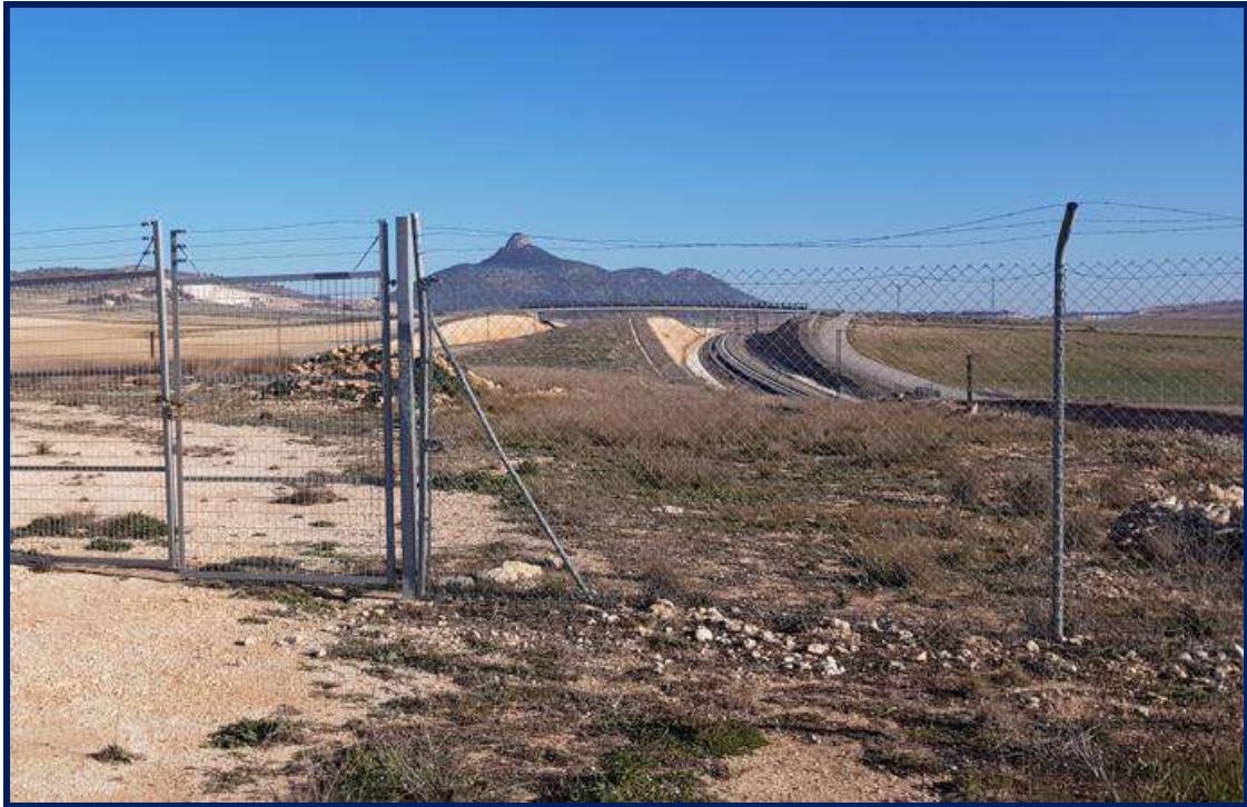
Ilustración 4 detalle de la línea de Alta Velocidad que parte las parcelas del parque
