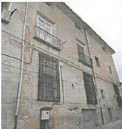
Fachada de la casa de los seis panes de Biar (Ubicada en un lateral de la Iglesia)
