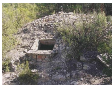
Exterior del pozo.
