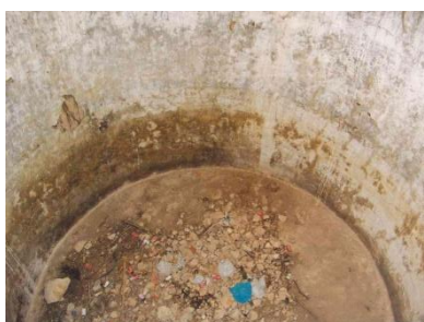
Interior del pozo.
