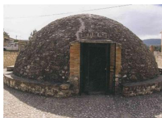
Exterior del pozo
