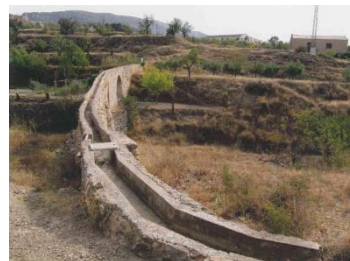
Acueducto Ojival, vista desde arriba.
