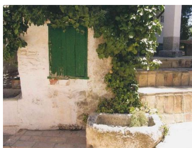
Imagen del aljibe y la pila.
